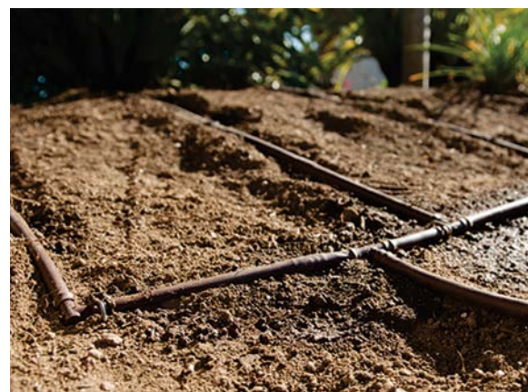
Nainštalované potrubie PLD
